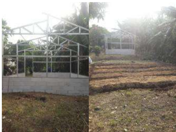
Gambar 15. Pembangunan rumah hidroponik
